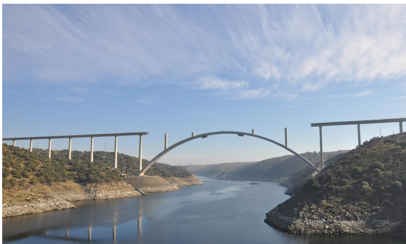
Viaducto sobre el río Tajo. Las obras siguen paralizadas
